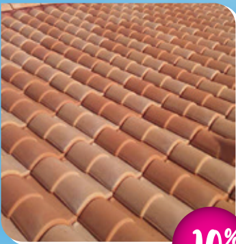
TRAITEMENTS TOITURES - FAÇADES
